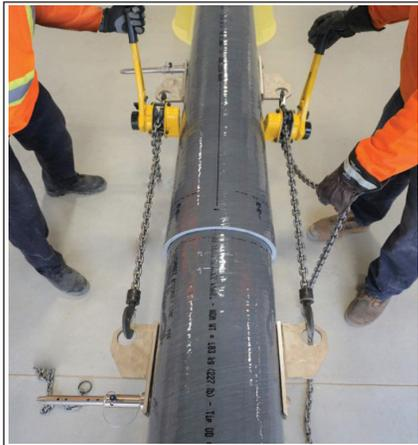
Figure 12 : Force d'assemblage égale appliquée des deux côtés
