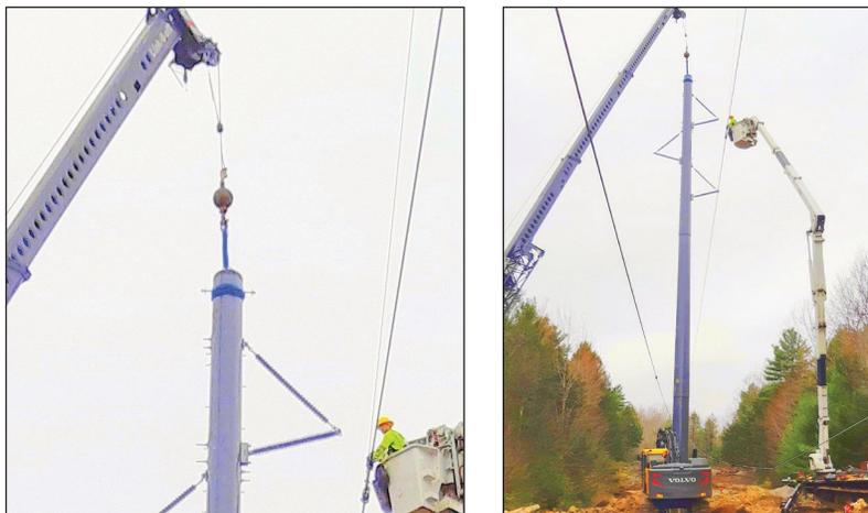
Figures 24a et 24b : Grue avec élingue à nœud coulant installant un poteau de 95 pi [29 m] pour un circuit de 115 kV
