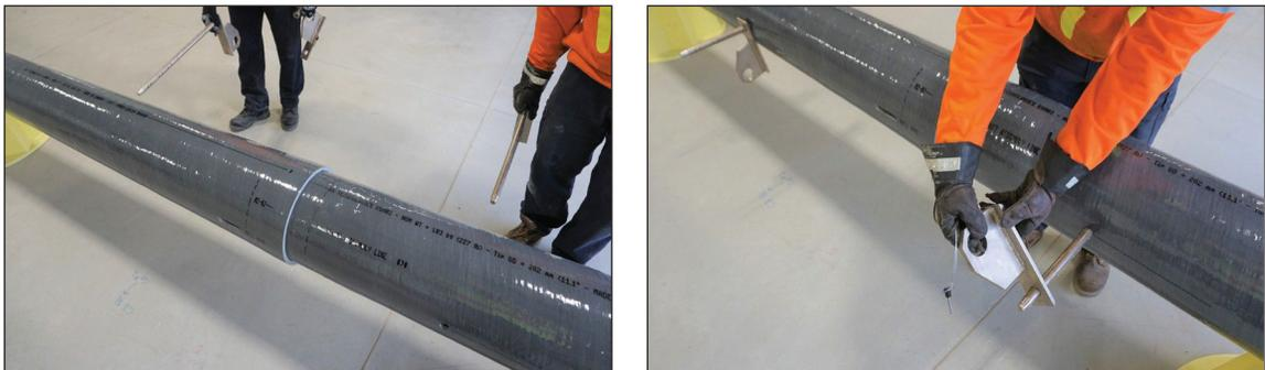
Figures 9a et 9b : Insertion des barres d'assemblage et ajout de la plaque d'assemblage
