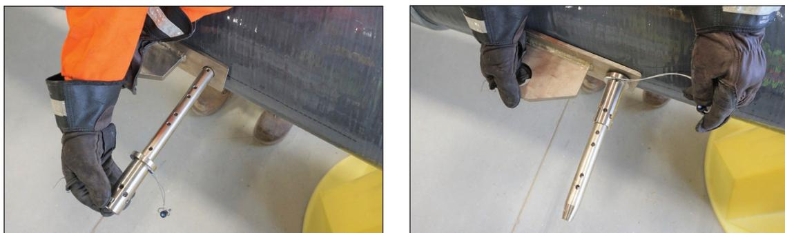
Figures 10a et 10b : Installation du collier de retenue et recherche du jeu de trous adapté pour un ajustement serré
