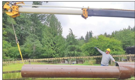
Figures 3a et 3b : Un camion-grue soulevant les modules vers le haut et vers l'extérieur pour les désemoîter et éviter les rayures
