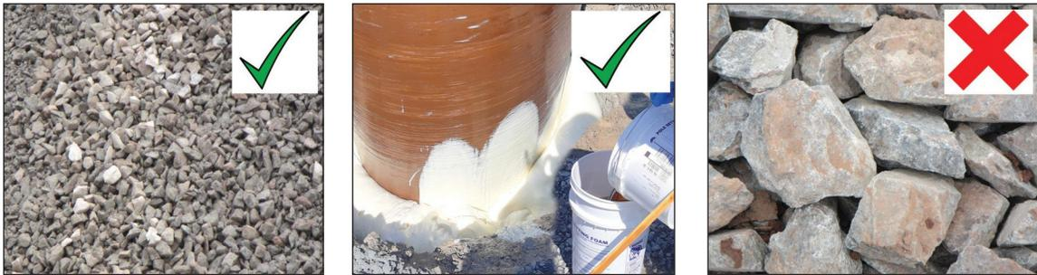
Figures 29a, 29b et 29c : Exemples d'options de remblayage acceptables et inacceptables
